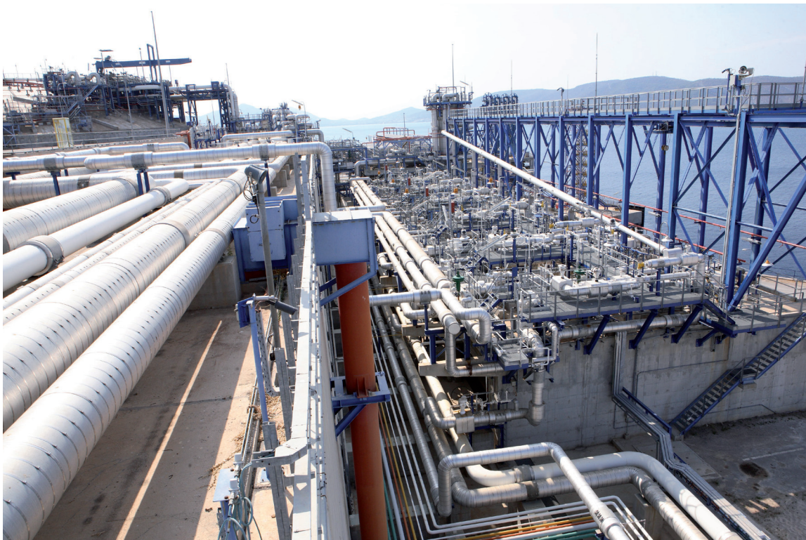
Revythoussa LNG terminal
